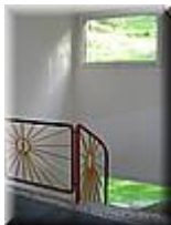
EM 040 Treppenhaus 2.OG
