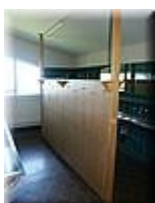
EM 052 Waschraum 2.OG
