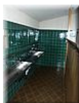
EM 053 Waschraum 2.OG
